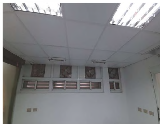
解剖室外四片活動式拉門(左)、抽吸式風扇七座(右)
