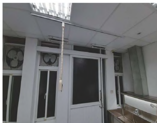
解剖台上方錄影、錄音設備裝置及解剖可移動式、懸吊式插座一座室內 24 小時監視錄影
