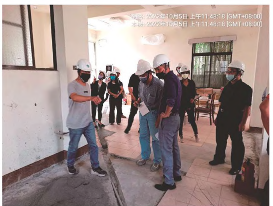
111. 10. 5 法務部施工查核-現場稽查
