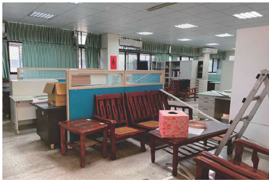
舊政風室等拆除中照片
