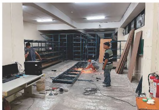
拆除舊贓證物置放架
