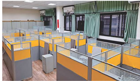
屏風桌椅施工中
