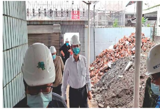
111 年 6 月 9 日陳盈錦檢察長到任後巡視耐震補強工程進度。
