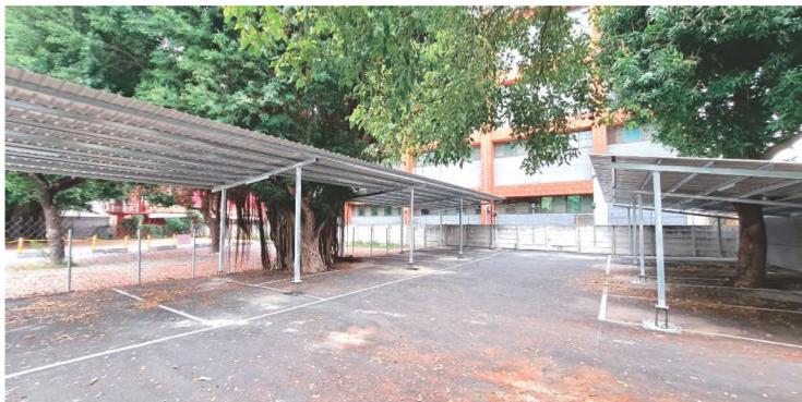
雨遮施工完成照片
