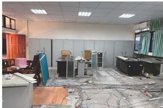
舊政風室等拆除中照片
