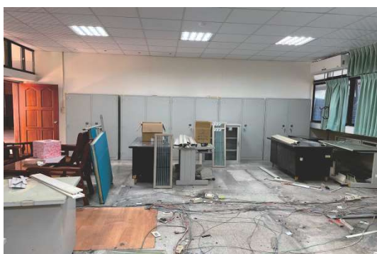
舊政風室等拆除中照片
