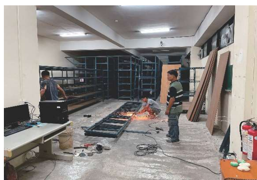
拆除舊贓證物置放架
