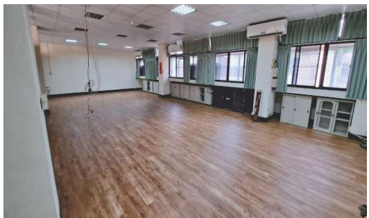
地板完工照片
