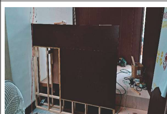
偵查庭施工中
