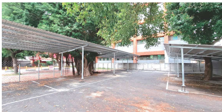
雨遮施工完成照片
