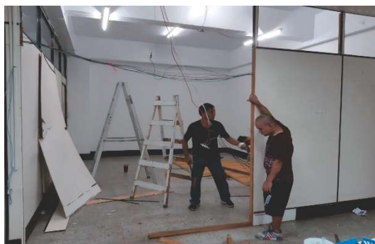
舊總務科含執行科部分檔卷室拆除
