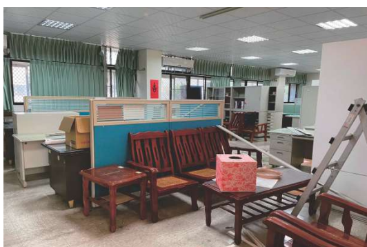
舊政風室等拆除中照片
