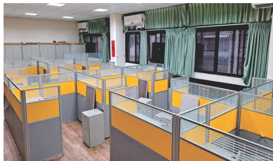
屏風桌椅施工中
