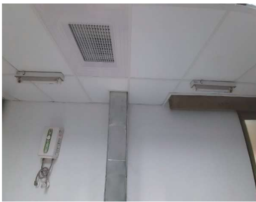
定時設定之紫外線殺菌燈管八座(左)解剖室內平釘花板及吸廢氣器座二座、嵌燈照明及屋頂抽(右)
