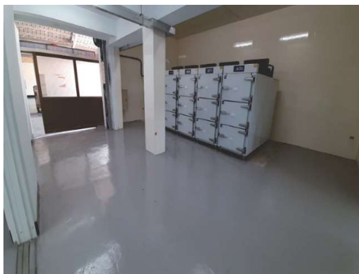
鋪設停屍間(Epoxy 環氧樹脂)(左)、遺體清洗室牆面及石磚地板整建(右)
