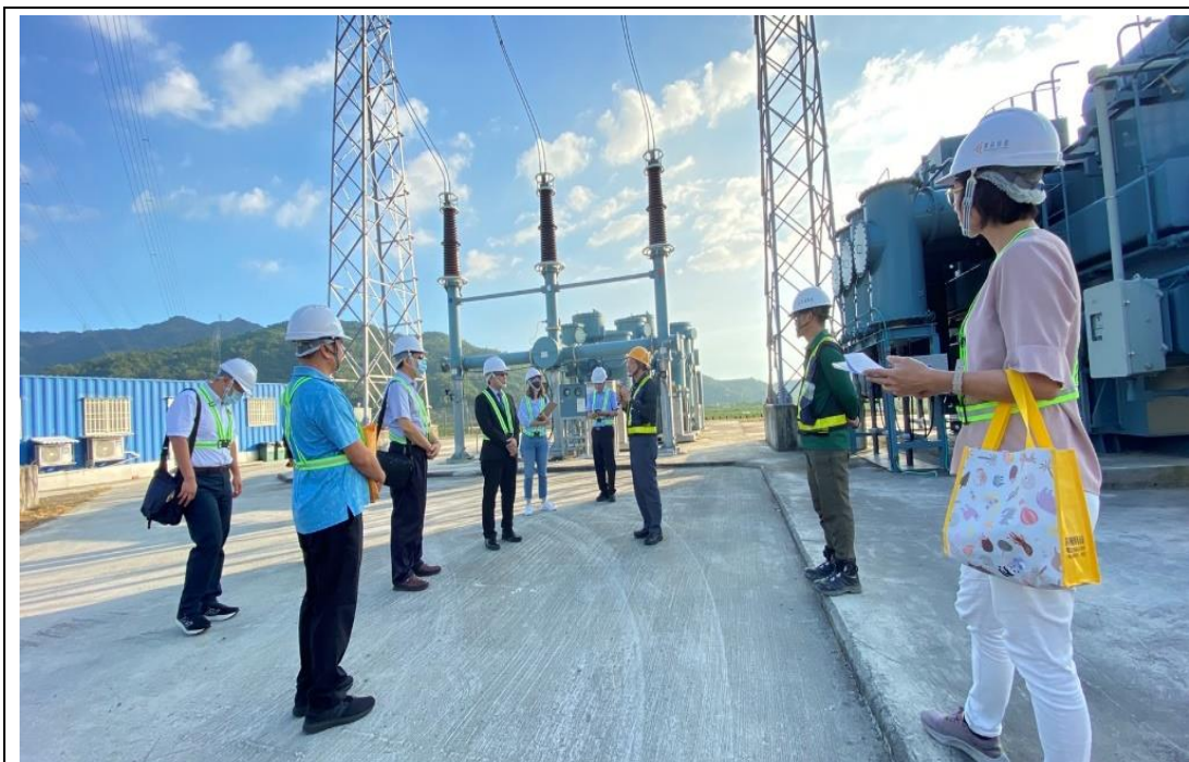
綠能業者向聯合訪視小組成員介紹太陽能光電場之設施設備
