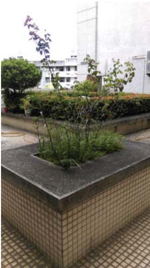
本署 2 樓露台（整修前）
