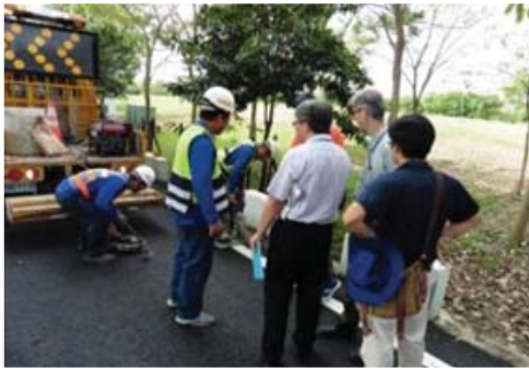
「屏東縣南二高橋下平面道路維護改善工程」實地鑽心取樣抽驗情形
