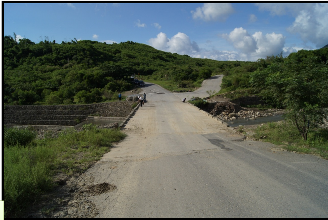
現場斜坡坡度情形
