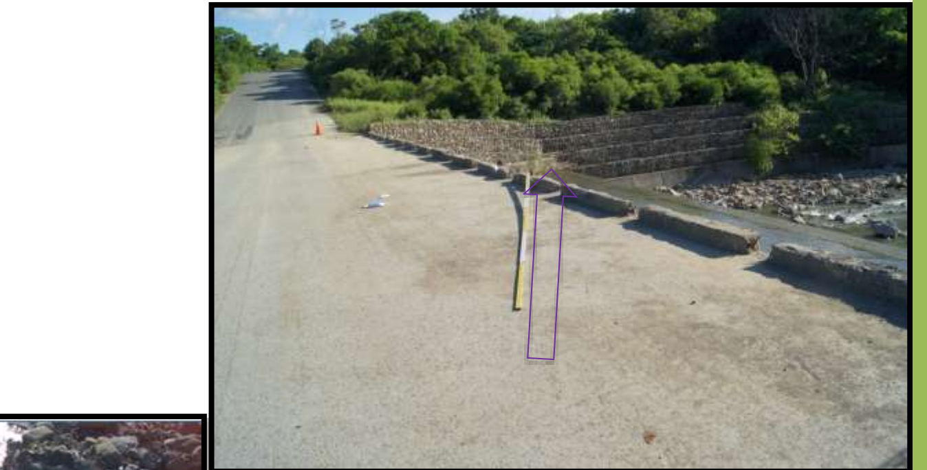
研判事故戰車碰撞護欄方向、角度及位置
