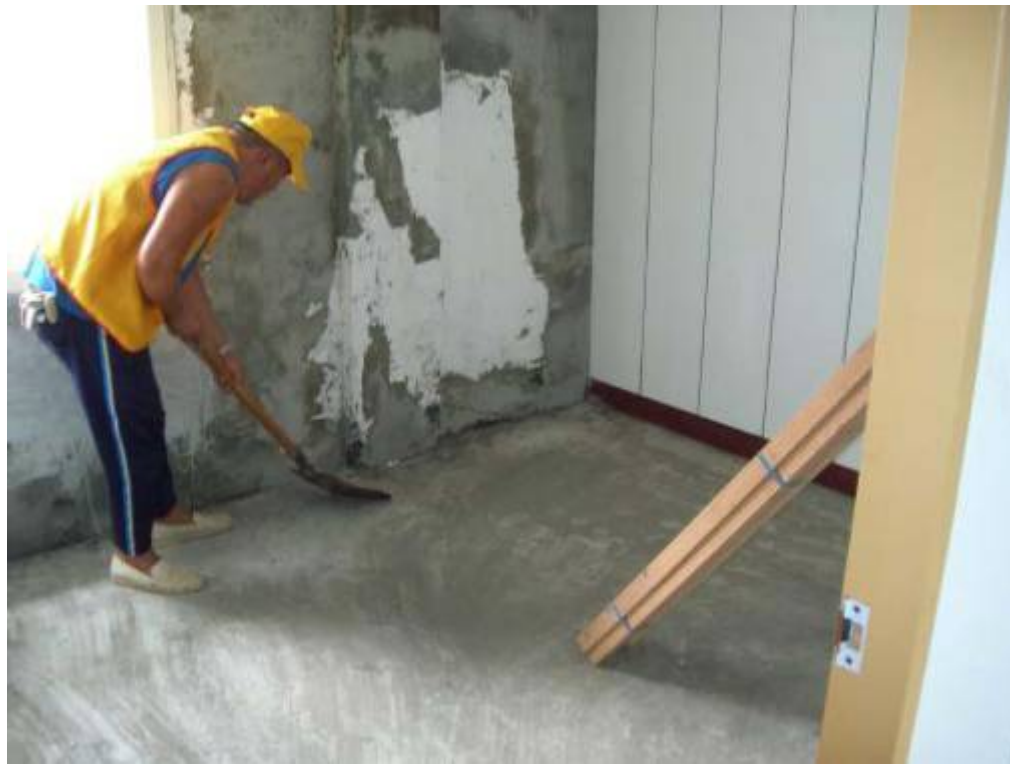
社會勞動人協助營區房屋修繕。
