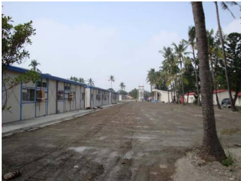
營區施工用地已整理完成。
