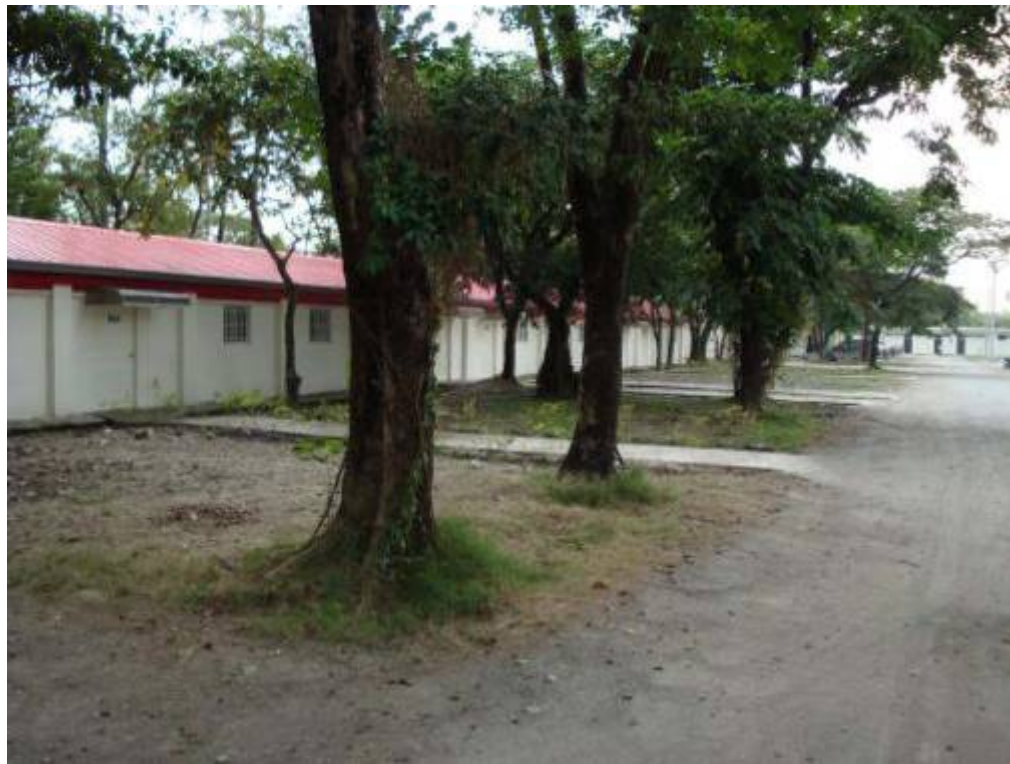
協助重建工作完成，整體環境清掃完畢，呈現整潔清幽的新面貌。
