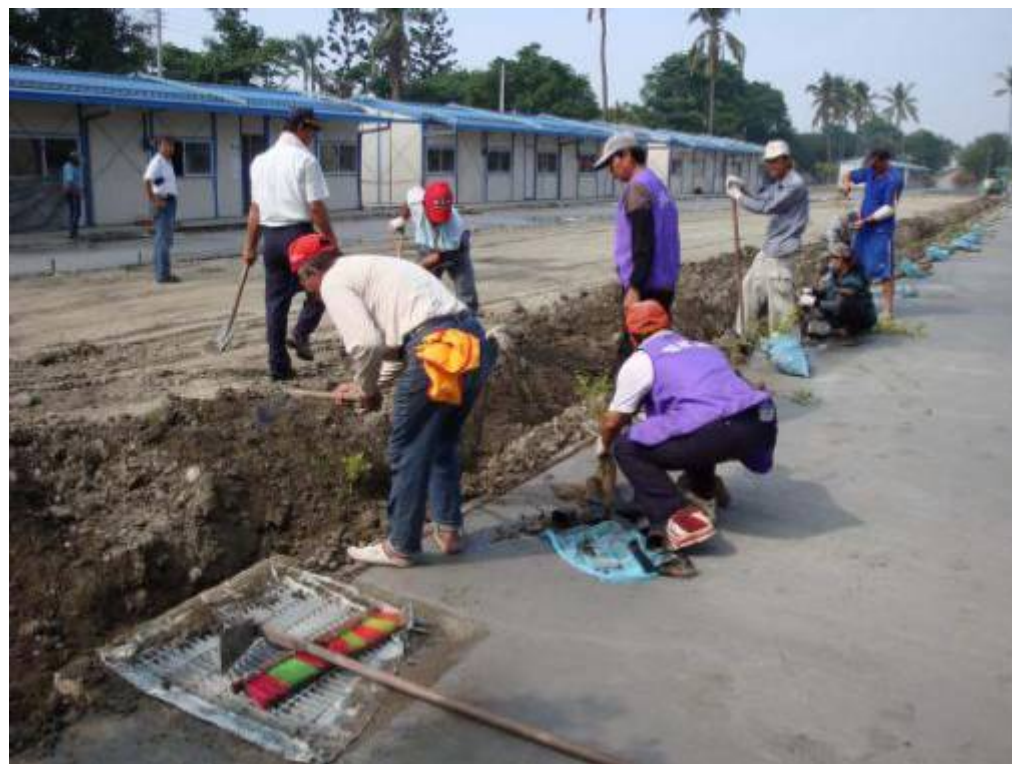
社會勞動人協助排水系統工程施工。
