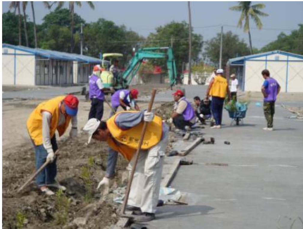
社會勞動人協助排水工程填土整地。
