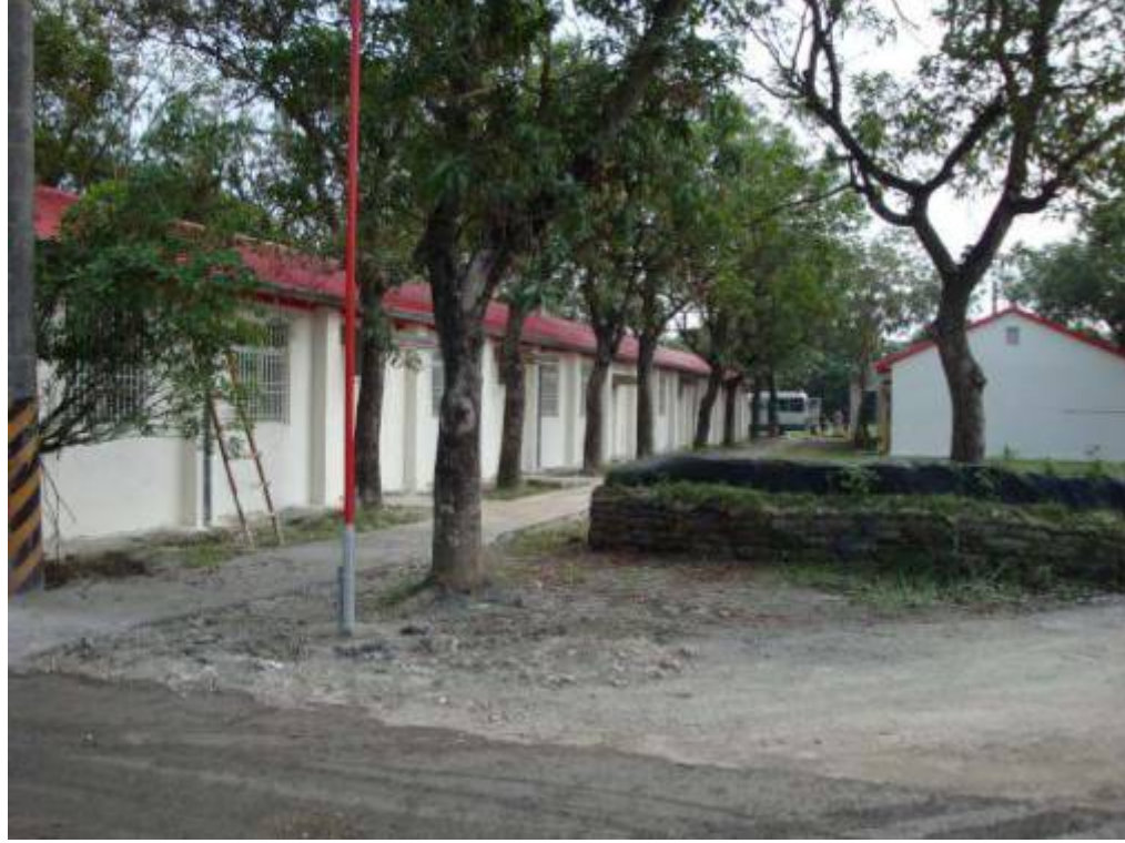
施工整地之垃圾已清運完畢。
