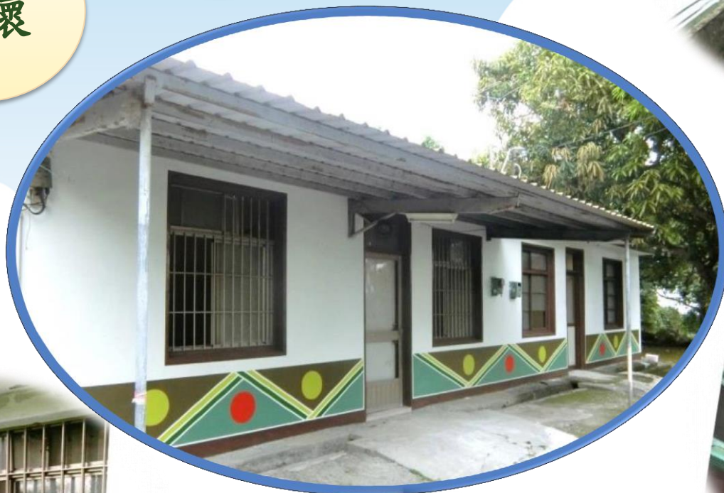
室內壁面粉刷
