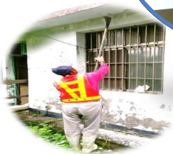
外牆舊漆刮除
